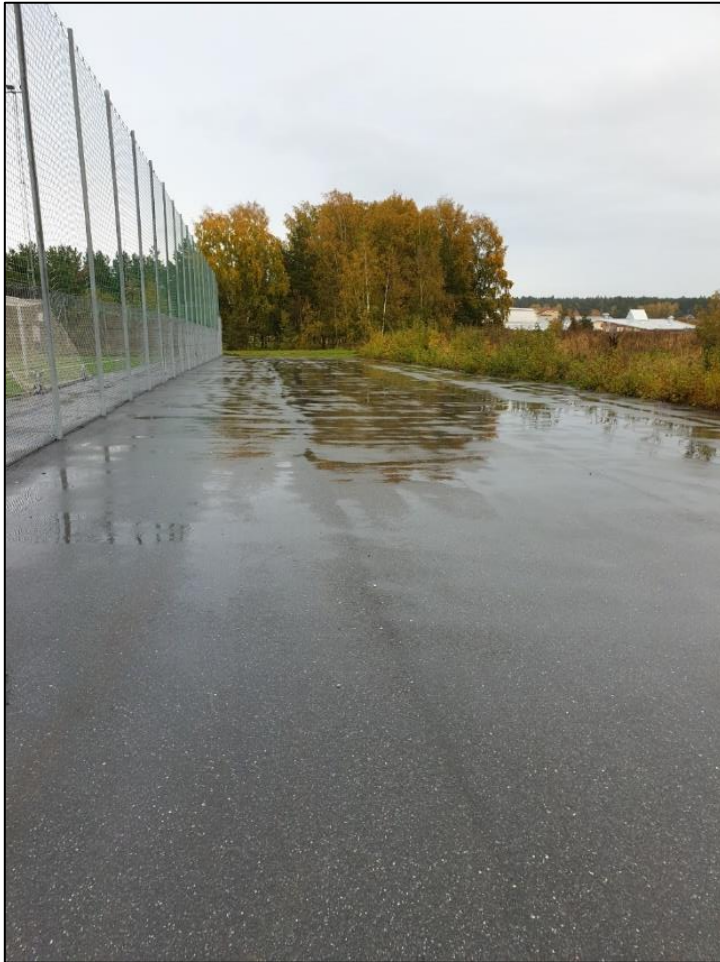
Figur 15. Asfalterad yta intill konstgräsplanens kortsida
